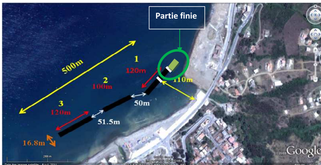
Fig. 24 : Phase actuelle de l'exécution des travaux dans la zone d'étude « La plage centre d'Azeffoun »
