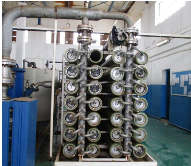
Figure 19 : Rack de tubes de pression d'osmose inverse de la station de dessalement de Palm-Beach (AA.ADEM, 2017)
