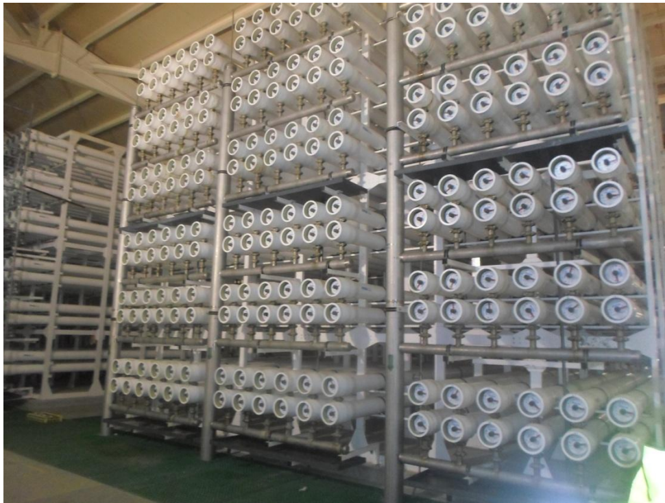
Figure 24 : Représentation de la filière d'osmose inverse de l'unité de dessalement de Fouka 1 (BRAHIMI et DINE, 2018)
