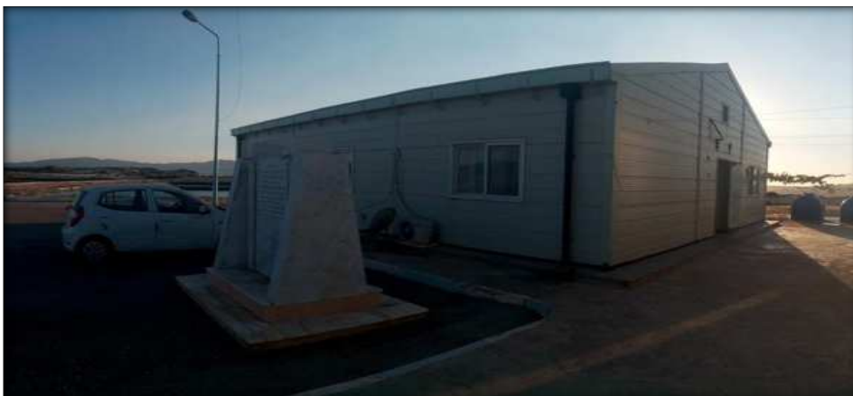
Figure 14 : Bâtiment de gestion, ferme pilote d'EL MARSA-Skikda
