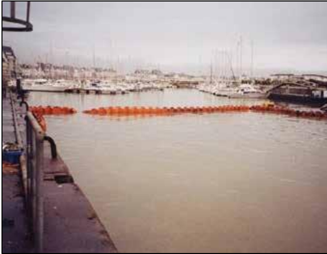
Figure I.32 : L'efficacité des barrages antipollution aux entrées des ports de plaisance peut être compromise si le barrage est endommagé lors des entrées et sorties de navires.
