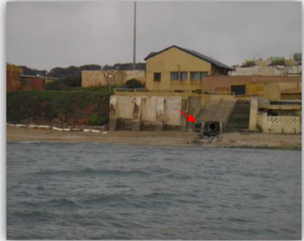
Photo n°2 : Une embouchure d'eau usée dans la zone.
