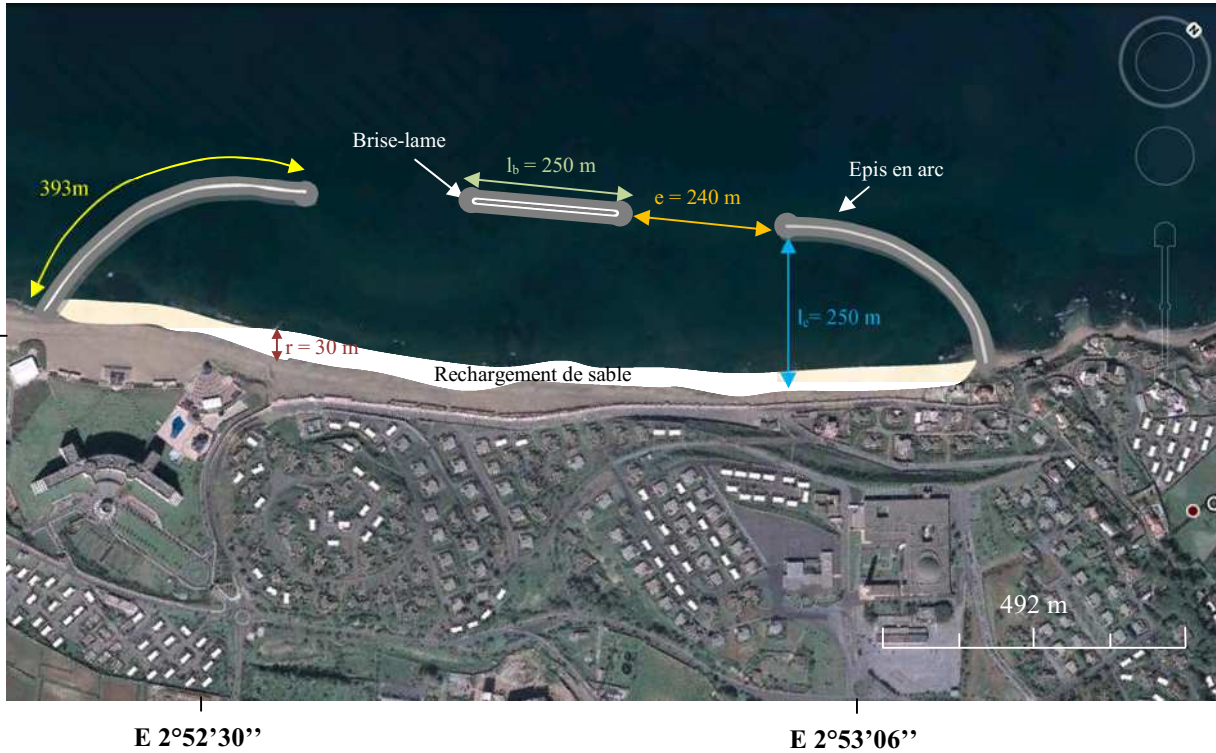
Figure n°69 : Installation de l'ouvrage mixte dans la zone de Club des Pins
