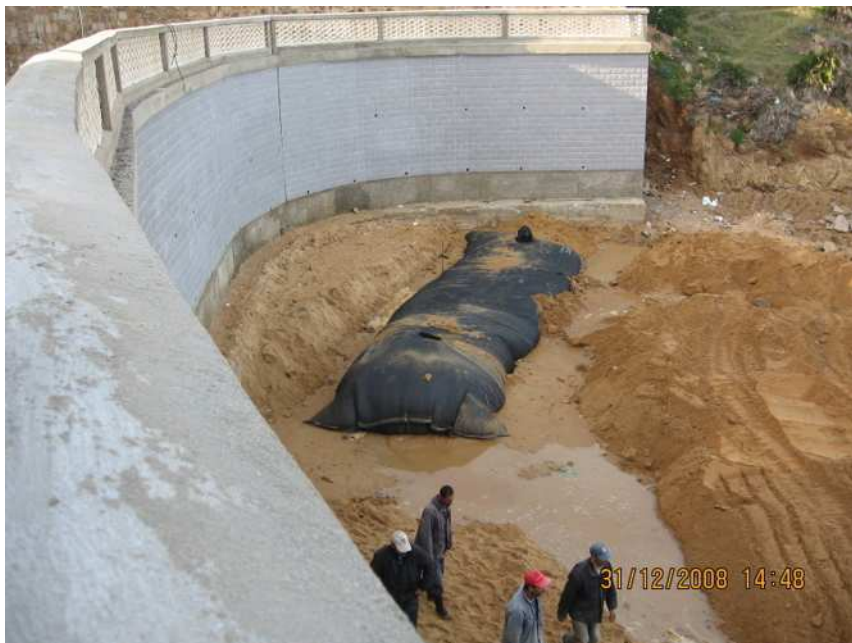
Photo n°10. Installation d'un géotube, (expérience à El Kala 2008)
