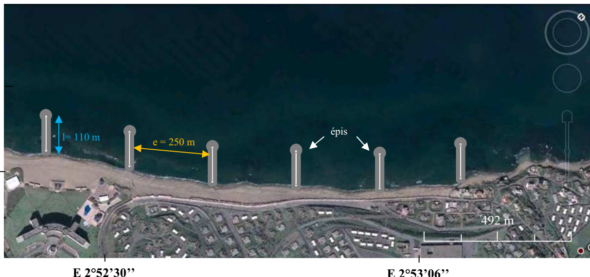
Figure n°66 : Installation des épis sur la zone de Club des Pins
