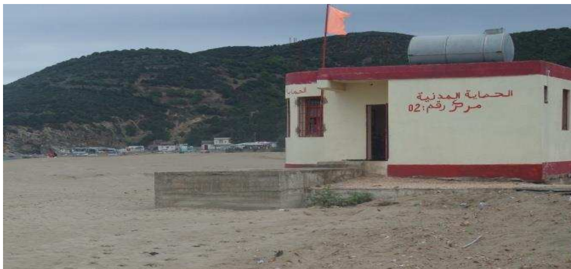
Figure 35 : des constructions dans la zone de servitude.
