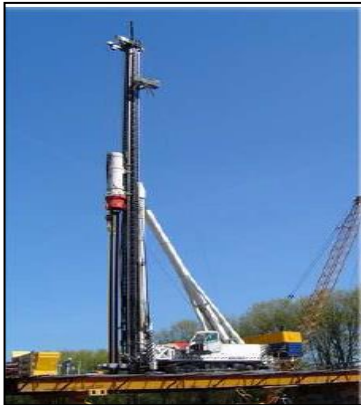
Exemple d'opération de battage
