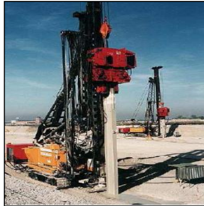
Figure 18: exemple d'opération de battage, fonçage et vissage
