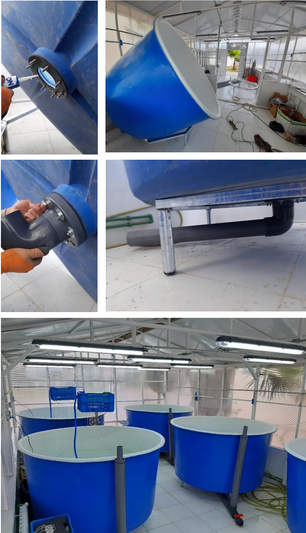
Figure 16 : Installation des bassins circulaire de la ferme.
