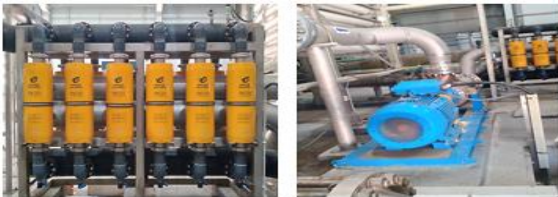
Figure 1: les échangeurs de pression (ERD) et la pompe booster
