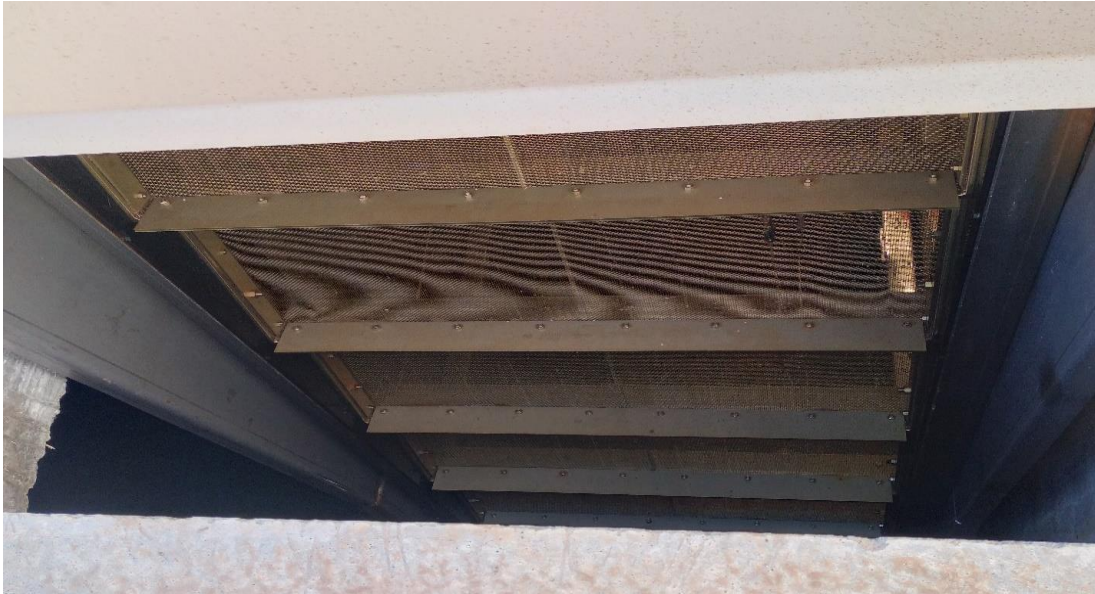
Figure III 6: Système de filtre rotatif installé au niveau de la station d'EL Marsa (Photo prise par AYOUNE et CHEAIBI)
