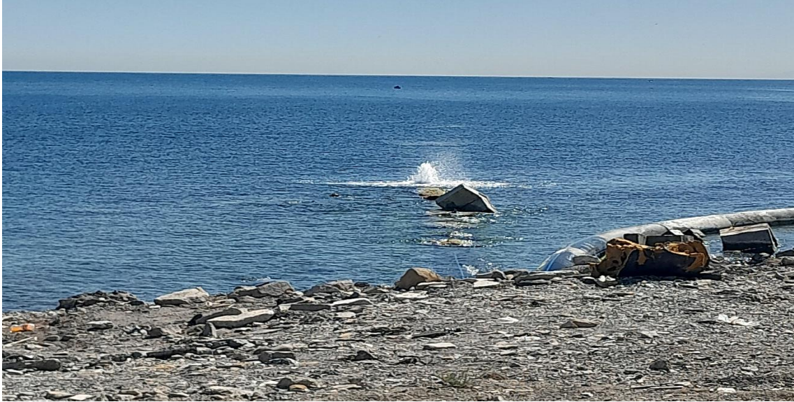
Figure III 11: Canal d'évacuation de rejets au niveau de la station d'El Marsa (Photo prise par AYOUNE et CHEAIBI)
