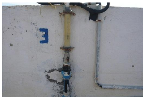
Figure n°10: moyens de réglage de l'O 2 dans l'eau
