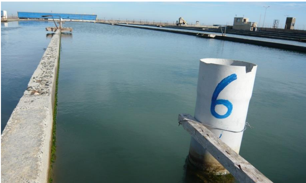
Figure n°11: bassins de grossissement
