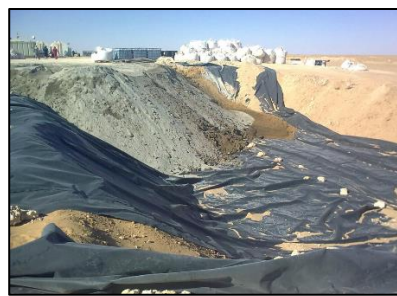
Figure 9 : Bourbier contenant le rejet sec (dry Pit)
