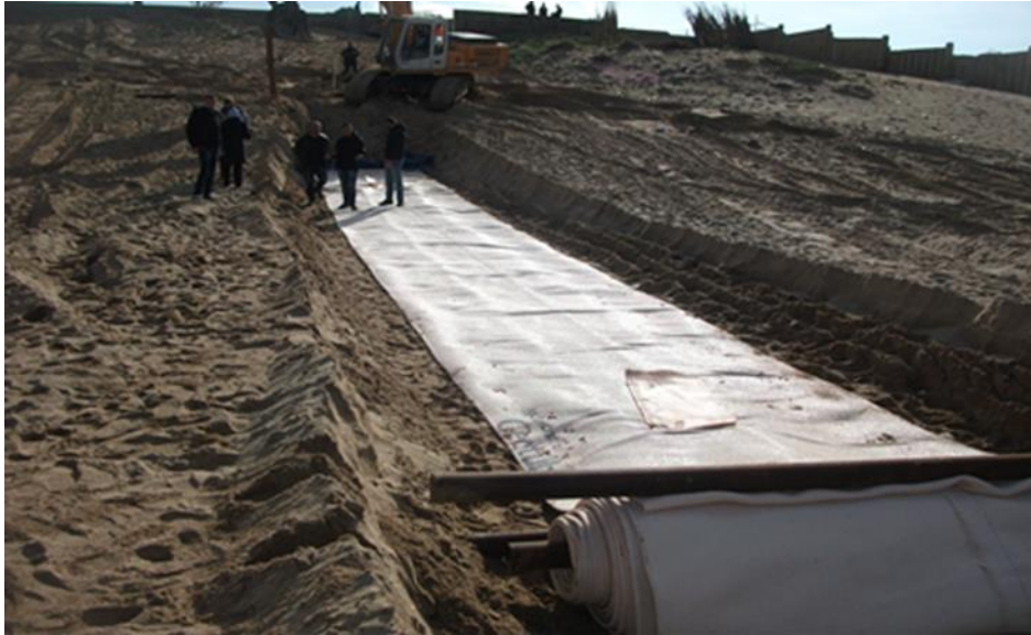
Figure 79:: Stabiilage en cours de mise en place
