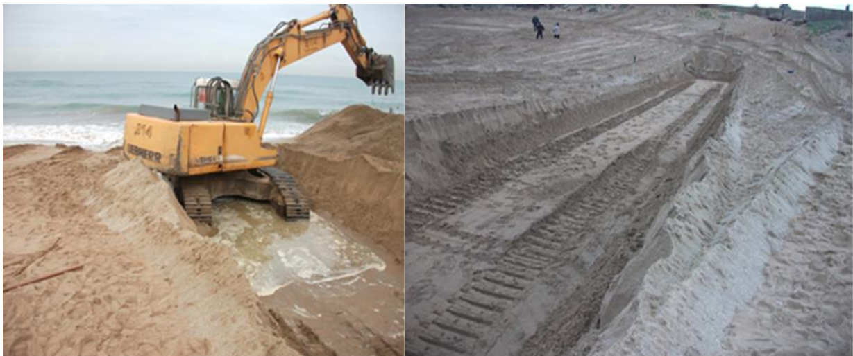
Figure 78:Fouille en tranché
