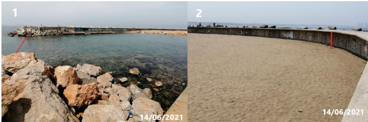
Figure 54: 1_ Digue de clôture (Plage d'El Djamila) 2 -Le volume de sable perdue au niveau de la plage artificiel
