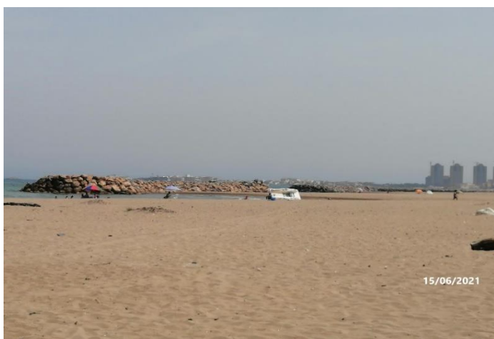
Figure 57: Ouvrages de protection (Plage Complexe touristique)
