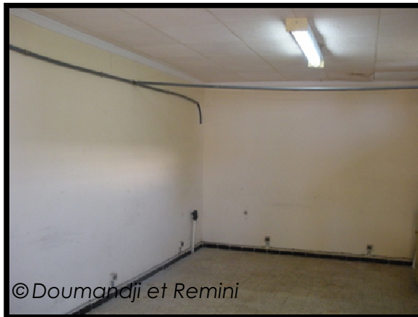
Figure 10 : Installation des tuyaux menant à la pompe d'aération.
