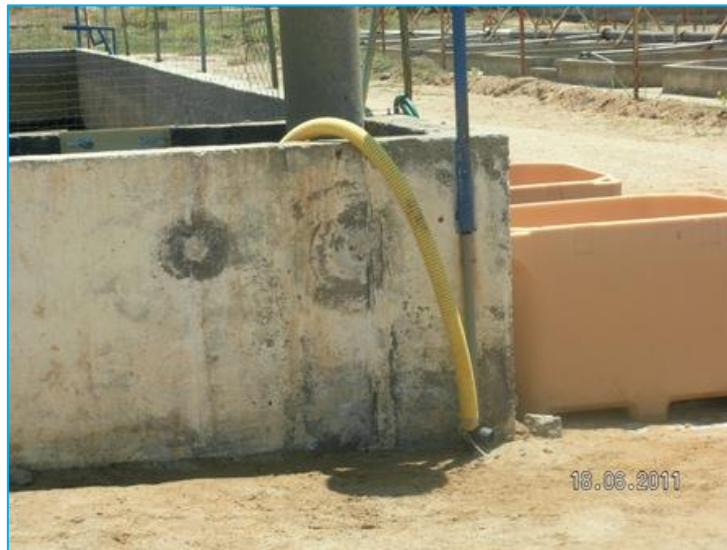
Figure 72 Flexible de prise d'eau
