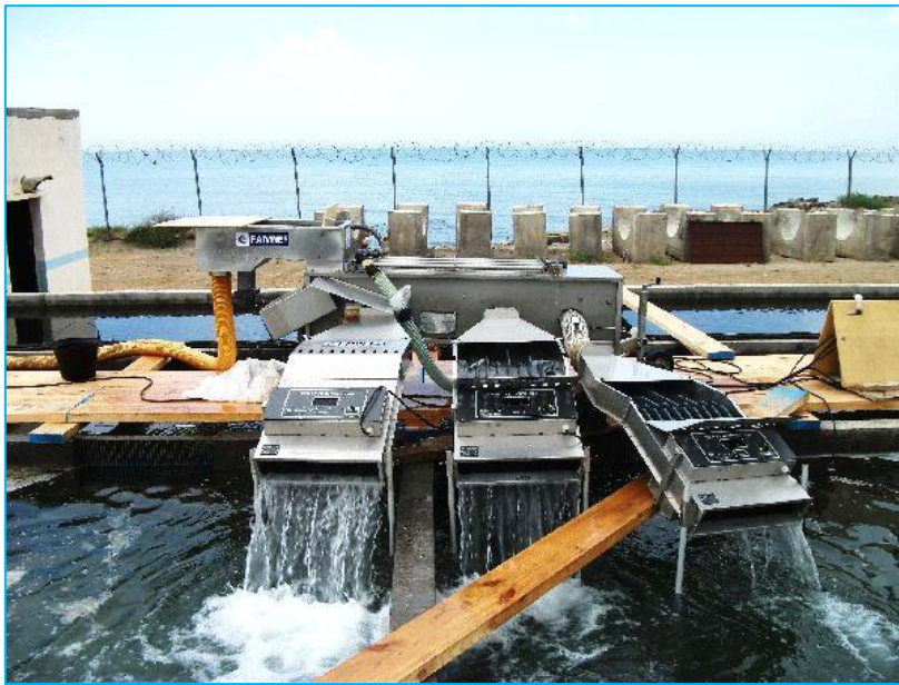
Figure 52 Compteurs de poissons
