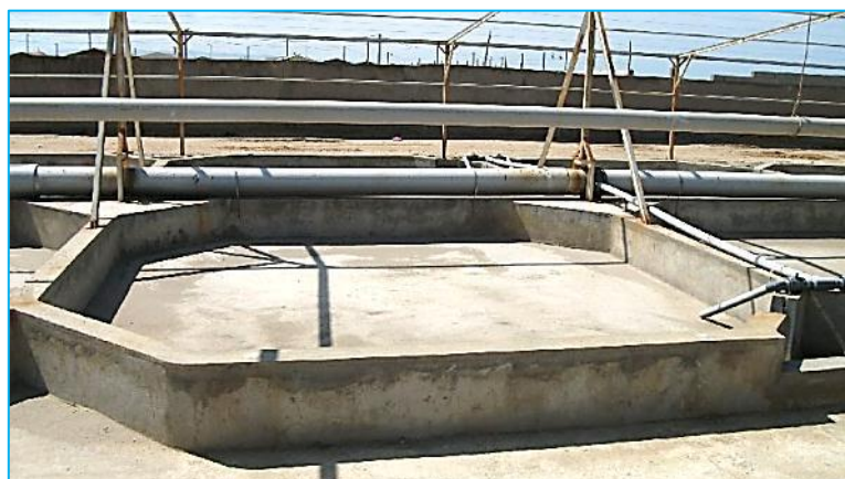
Figure 25 Bassin de pré-grossissement de Sole
