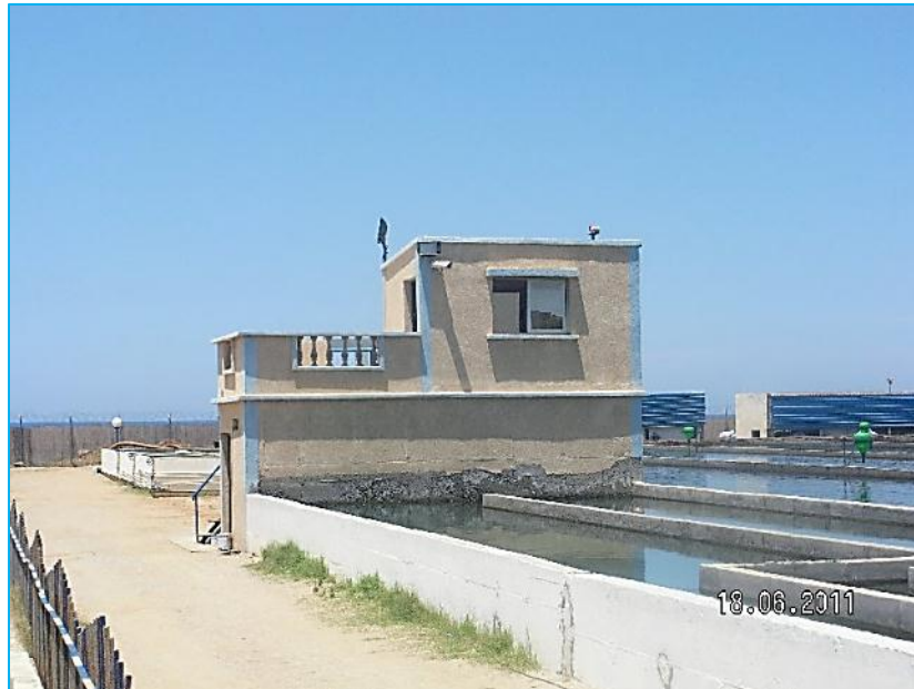
Figure 49 Tour de contrôle
