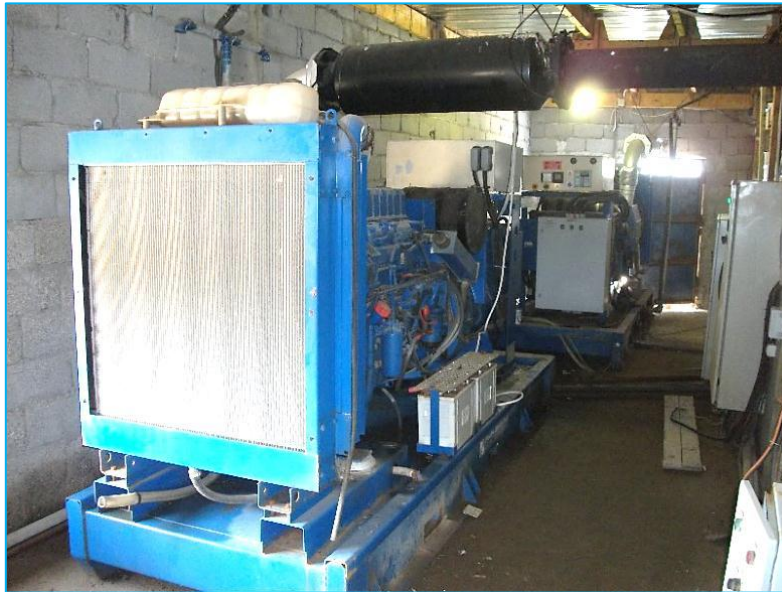
Figure 47 Les deux groupes électrogènes
