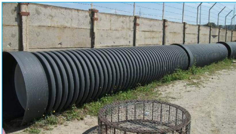
Figure 34 Conduites prévues pour la prise d'eau non réchauffée (au large)
