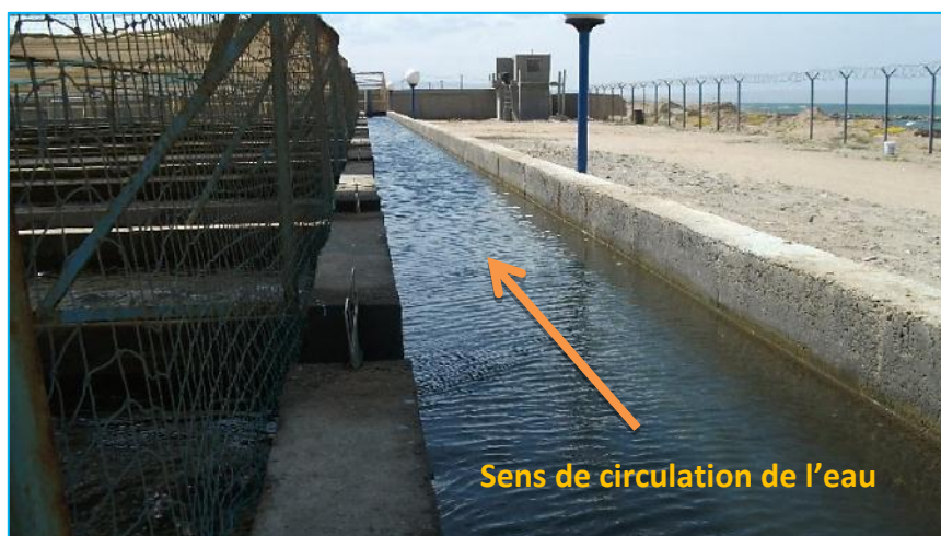
Figure 41 Canal d'alimentation des bassins de pré-grossissement de Loup et Daurade
