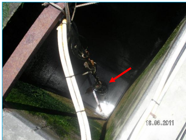
Figure 36 Pompe immergée (à l'arrêt)
