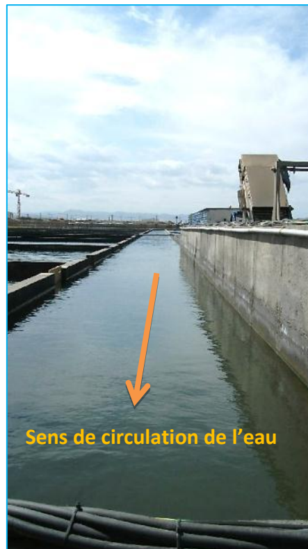
Figure 42 Canal d'alimentation des bassins de grossissement
