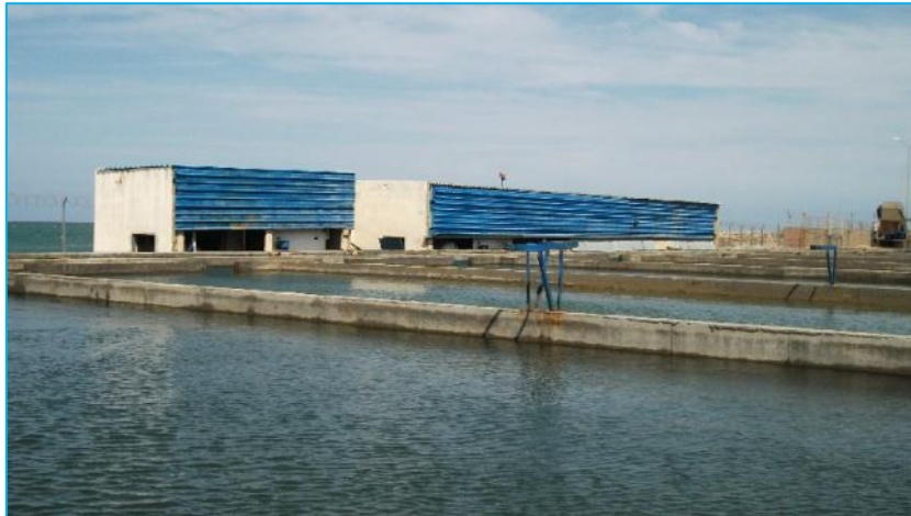
Figure 39 Emplacements des machines à oxygène et des groupes électrogènes
