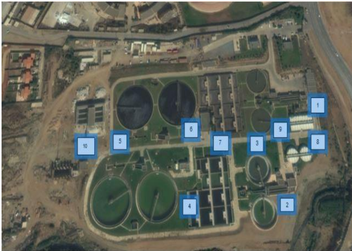
Figure II.4 Vue d'ensemble des ouvrages de la STEP de Béni Messous par Satellite (OULEBSIR, R., 2020).
