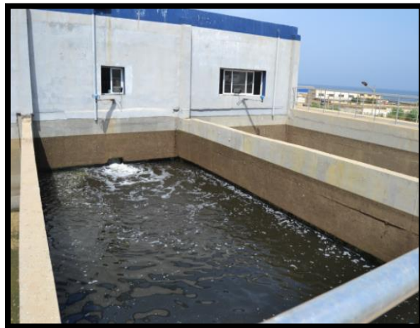
Figure II.10 Batterie filtrante en mode filtration ( Notice de Fonctionnement et d'exploitation de la station d'épuration de Beni Messous mise à jour 2021 ).
