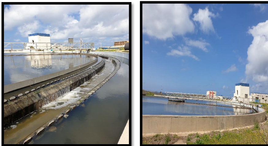
Figure II.9 : Décanteur secondaire ou clarificateur ( KENNICHE, D., et BOUKHARI, I. ).
