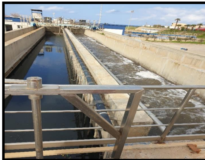
Figure II.6 : Dessablage-Déshuilage (KENNICHE, D., et BOUKHARI, I).
