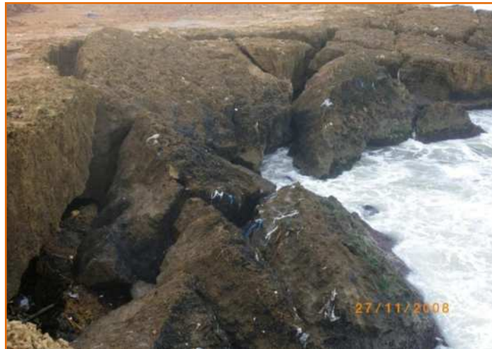
Figure II.32: Eboulements des roches à Fouka Marine.
