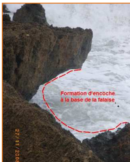
Figure II. 11 : Présence d'encoche au niveau des falaises de Fouka Marine
