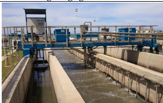
Figure II.08 : Photographie de la filière de dessablage déshuilage
