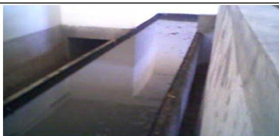
Figure II.05 : Photographie de déversoir d'orage
