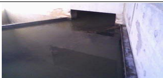
Figure II.05 : Photographie de déversoir d'orage
