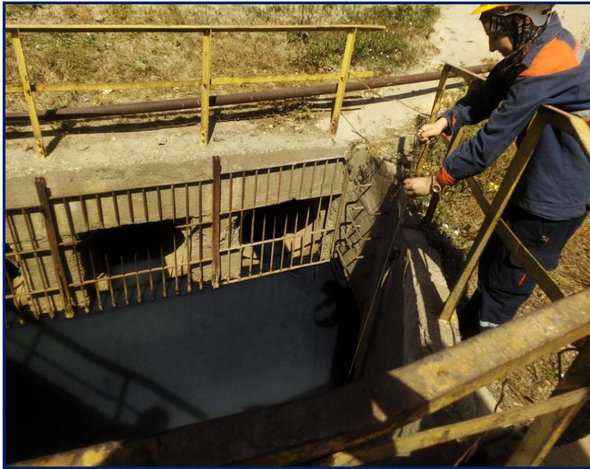
Figure 5 : Prélèvement des eaux de rejet en aval des filtres à foin (fosse A).
