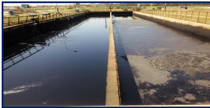
Figure 2: Bassin des eaux huileuses (Bassin de décantation API) de la station de traitement des ERI de la raffinerie d'Alger.
