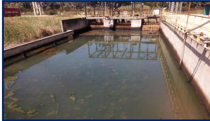
Figure 1: Bassin des eaux non-huileuses (pluviales) de la station de traitement de la raffinerie d'Alger.
