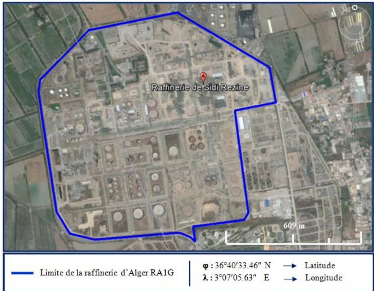
Figure 2 : Vue aérienne de la raffinerie d'Alger (Sidi Rezine) RA1G (Google Earth, 2016).
