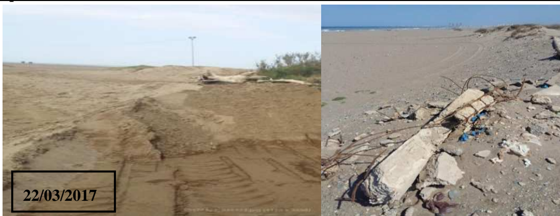
Figure 12: Illustration de l'état dégradé des dunes de Zeralda
