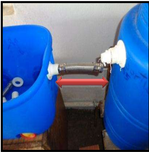
Figure 6 : Tuyau fixable de 26 mm relié le filtre à tourbillon avec le filtre mécanique
