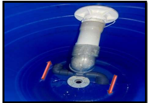
Figure 23 : L'entrée d'eau vers le bio-filtre
