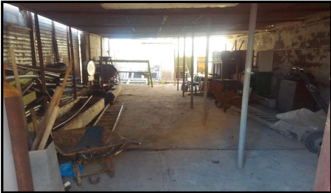
L'état de la ferme le 24-02-2017
