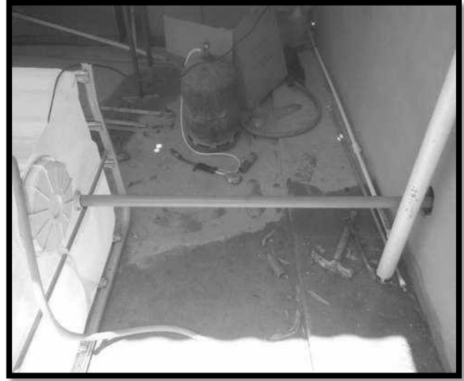
Figure 44: Raccordement du canal d'évacuation avec le bac de récupération
