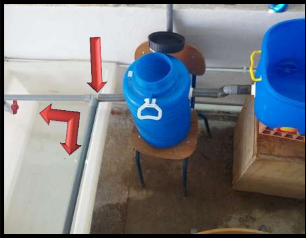
Figure 40 : La sortie d'eau vers le système Hydroponique
