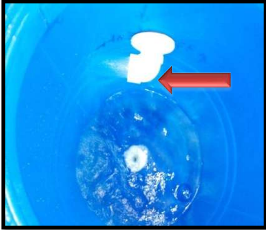
Figure 14 : L'entrée d'eau par un coude PVC 90°
