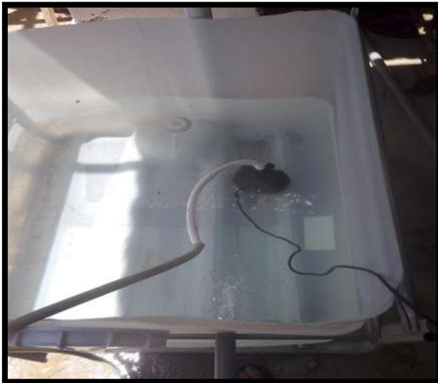
Figure 46 : Pompe submersible au fond du bac
