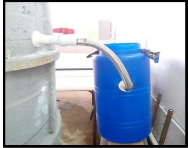
Figure 13 : Accordement du bassin d'élevage des poissons avec le filtre à tourbillon
