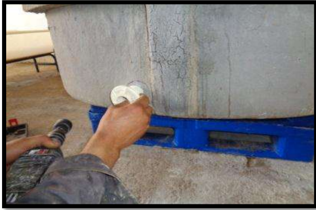
Figure 11 : Positionnement de trou sur le bas du bassin
