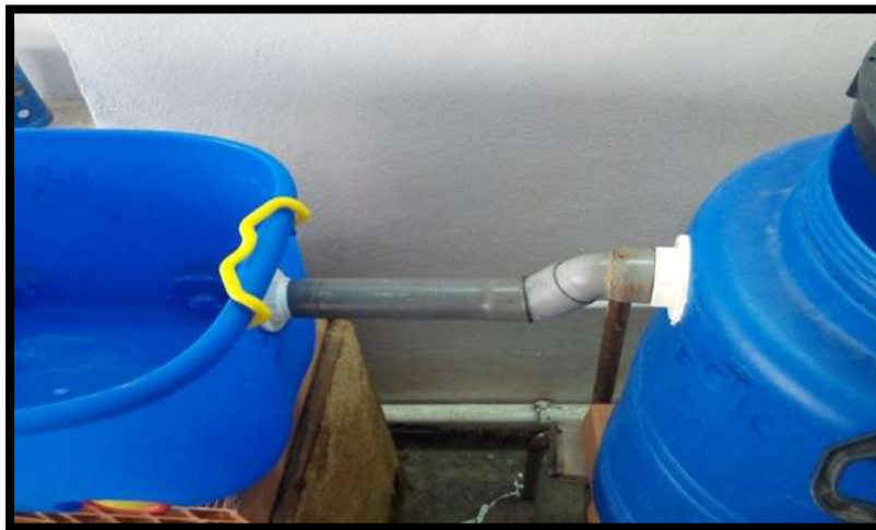
Figure 19 : L'emplacement du filtre mécanique
