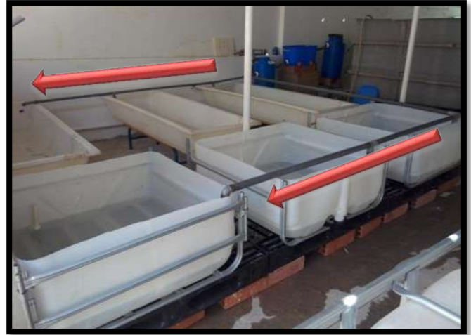
Figure 41 : Les tuyaux de distribution d'eau pour les bacs de culture
