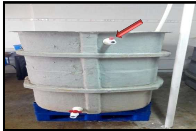
Figure 9 : Trop-plein de sécurité
