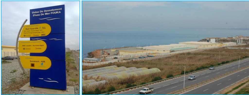
Figure III.4 : Photo de la station de dessalement Fouka.
