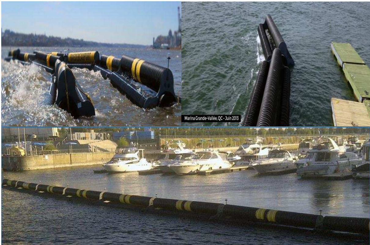
Figure 7.2 : la structure et la configuration d'un brise lame narval.
