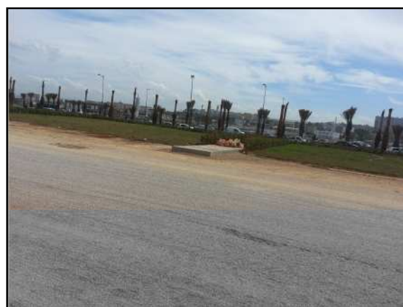
Photo 4 : achèvement des travaux d'une partie de projet
