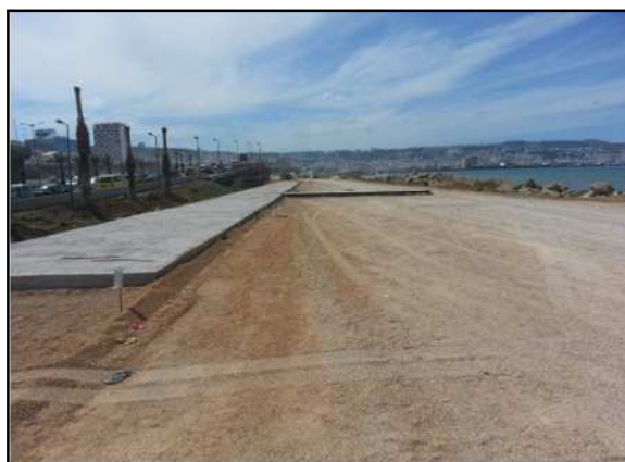
Photo 3 : phase de réalisation des aménagements terrestres
