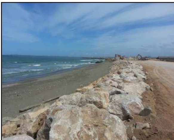
Photo 5 : protection par une digue en enrochement
