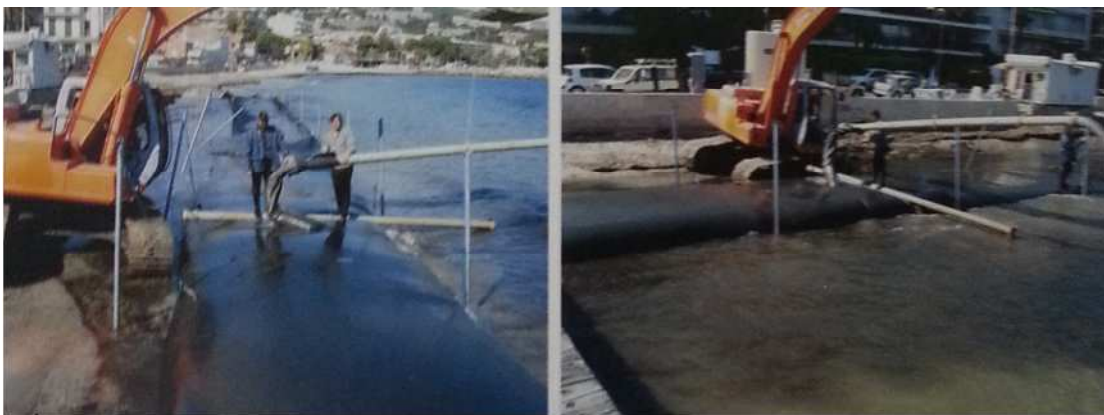
Photo n°8. Installation d'un géotube, (plage du MORE ROGE, CANNES)
