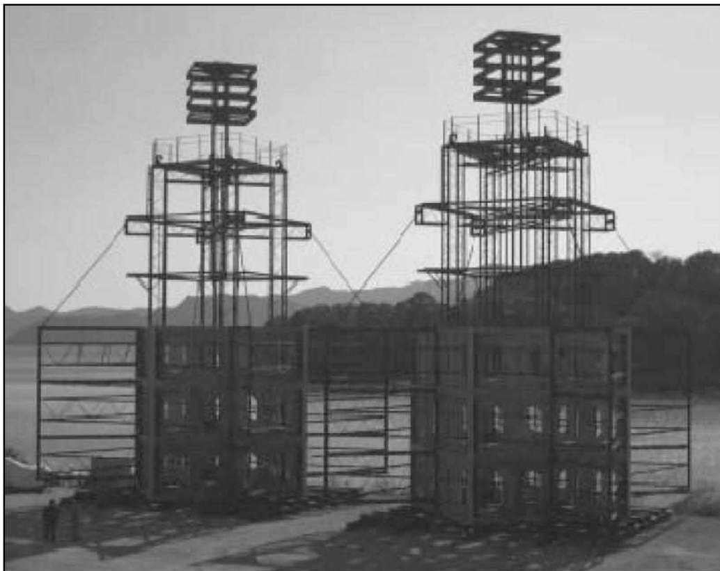
Figure 11 : Modules de récifs en métal et béton de 20 m de haut au Japon ( Pioch, 2006 )
