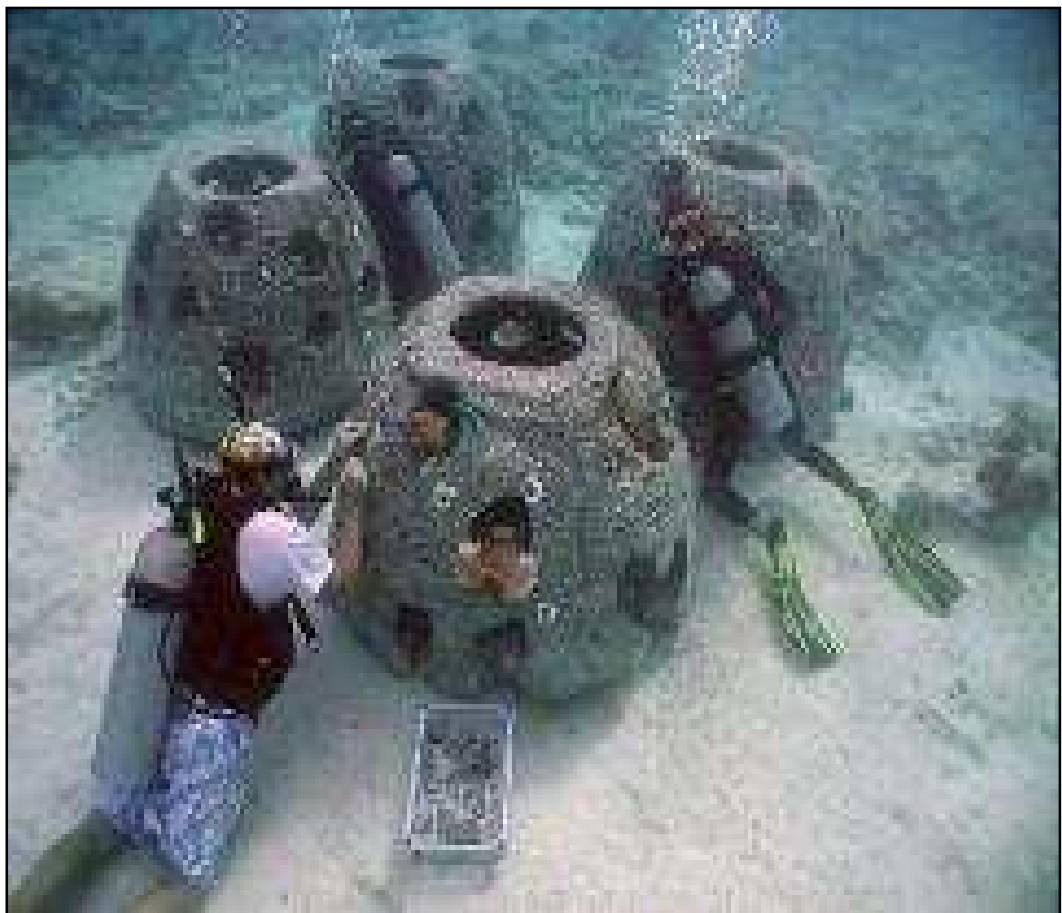
Figure 6 : Mise en place de ReefBall ® . (Harris et Woodring 2001). (source : www.reefball.com )
