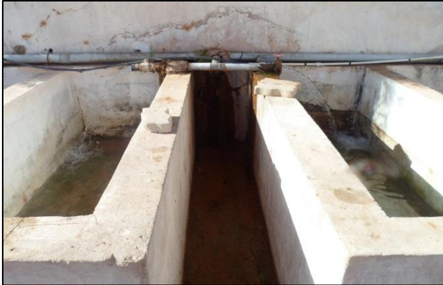
Figure 15 : Bassins en béton
