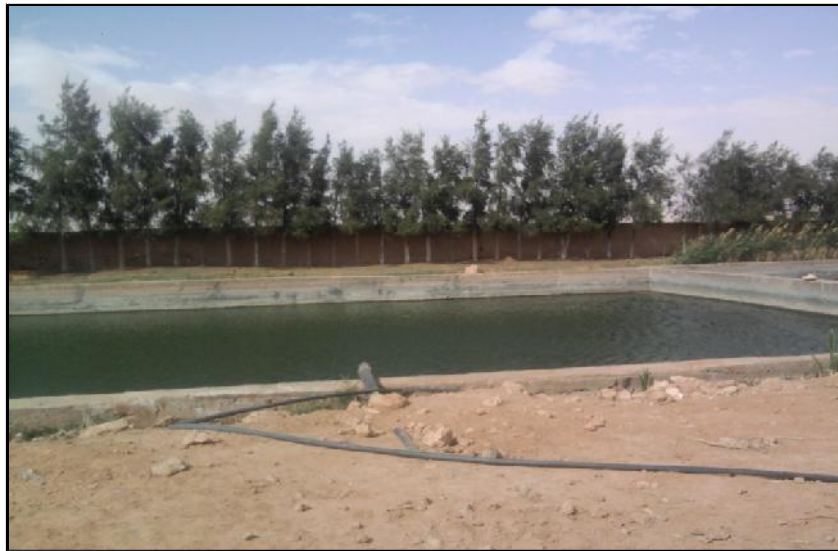
Figure 09 : Bassin de décantation
