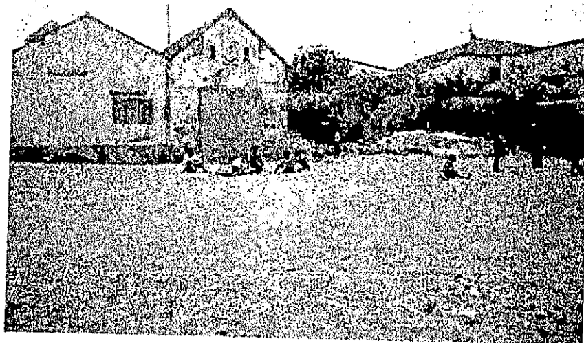
Photo 5 : Construction de type « pied dans l'eau » au niveau de la plage « centre » de Bordj-El-Kiffan.
