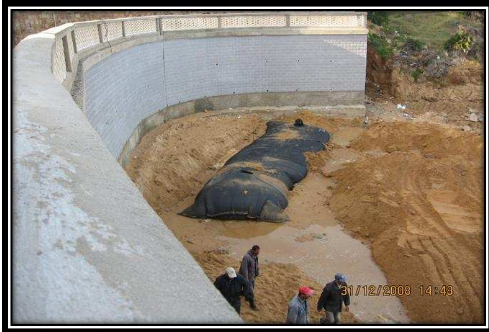
Photo III.1 : Installation des géotubes (El KALA 2008).
