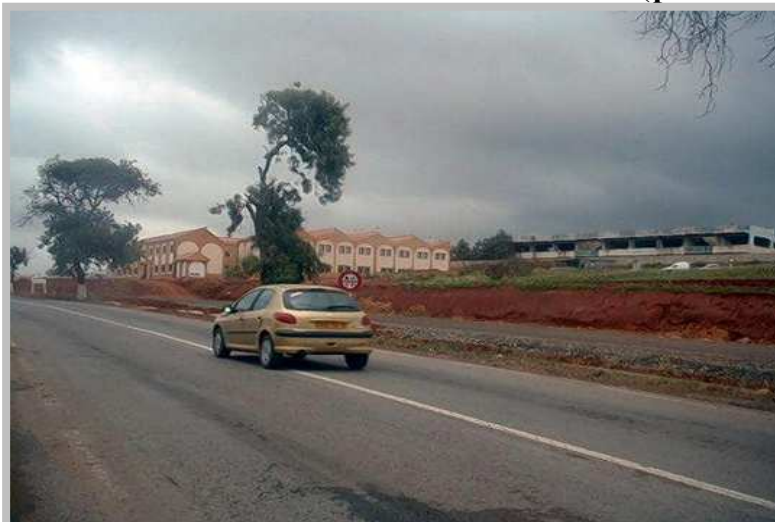
Photo N° 08 : Travaux d'élargissement de la RN 11 réalisés (entrée de Tipasa ouest)
