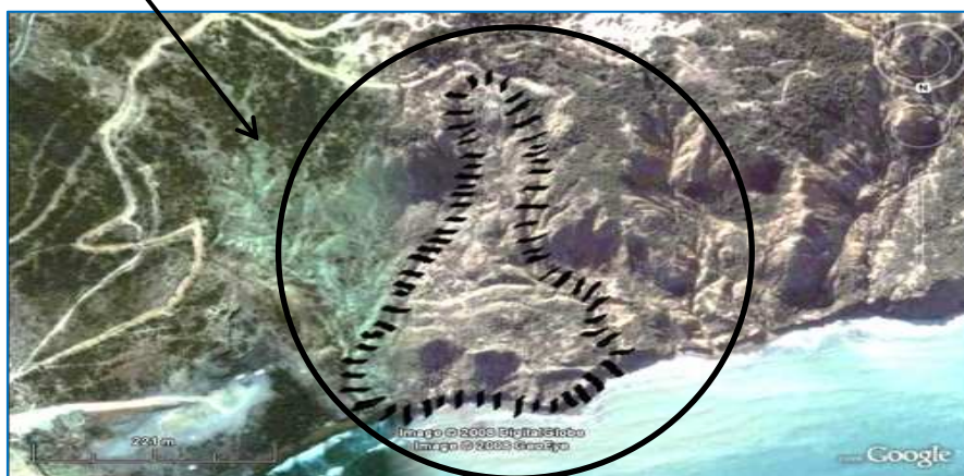
Figure II. 6: Glissement secondaire stabilisé (Google Earth, 2017).
