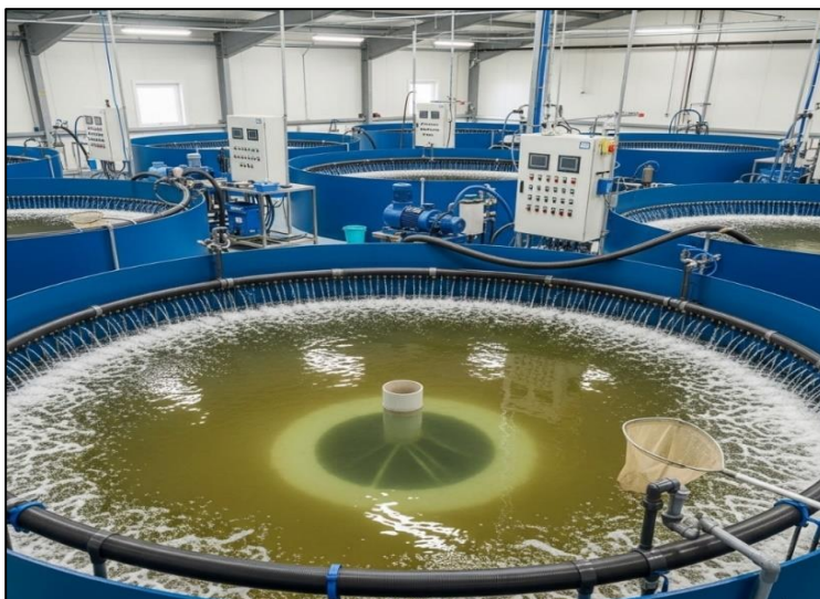
FIGURE IV.05 : Bassins de pré-grossissement (généré par IA)
