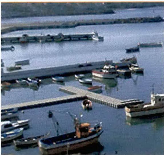
3) Vue générale des bassins
